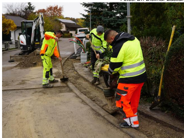
Wiederherstellung der Gehwege
