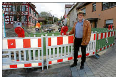
Die Wiernsheimer Lindenstraße wird aktuell beim 1. Bauabschnitt auf Höhe des Friedhofes bis Haus Nr. 32 an der Ecke zur Einmündung der Schanzstraße neu gestaltet.
